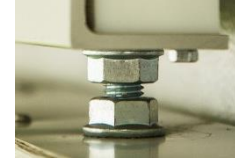
COLGADOR EN RANURA DE TROLLEY CON TUERCAS DE FIJACIÓN Y AJUSTE
